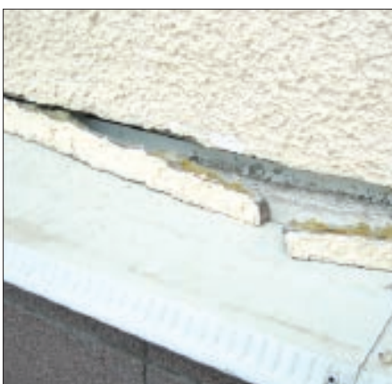
Примыкание системы теплоизоляции к цокольной части здания выполнено жестко, без учета возможных расширений и деформаций, без использования деформационных материалов
