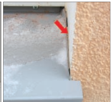
Установка отливов произведена жестко, без формирования необходимого деформационного шва. Отливы установлены с зазором и дают возможность проникновения воды вглубь теплоизоляционной плиты
