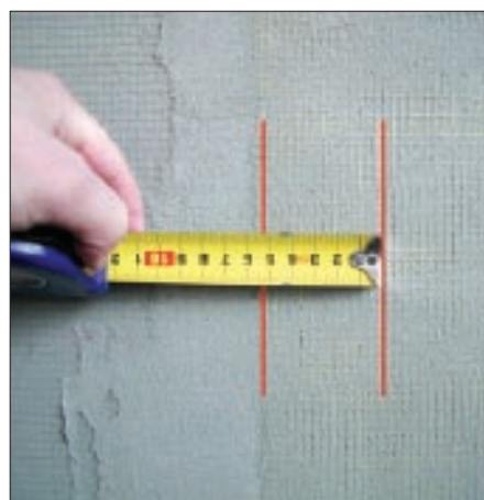
При установке армирующей сетки обязательный перехлест соседних полотен отсутствовал или составлял менее 100 мм.
