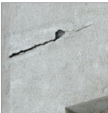
При установке армирующей сетки обязательный перехлест соседних полотен отсутствовал или составлял менее 100 мм.
