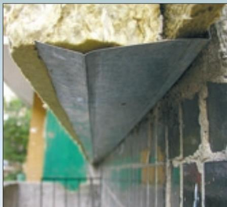
Несоответствующий выбор цокольного профиля под размер используемой теплоизоляционной плиты. Деформация цокольного профиля в процессе установки
