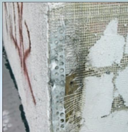
*Разрушение системы теплоизоляции вследствие механических воздействий*
