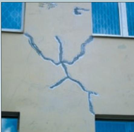
Попытки ремонта теплоизоляционной системы. Расшивка трещин и последующее заполнение цементно-песчаными растворами
