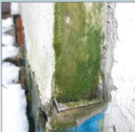
Разрушения, плесневые и мховые поражения из-за неправильного завершения системы теплоизоляции на внешнем углу здания
