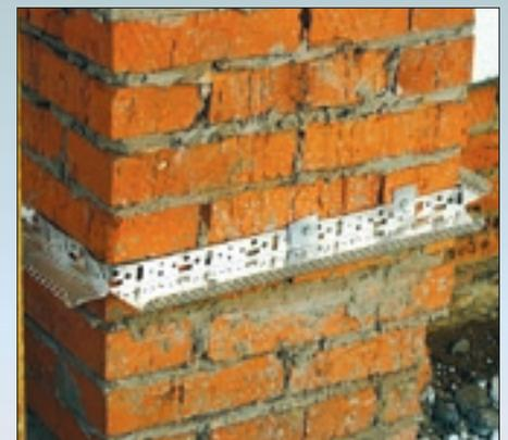
*Последующее полное или частичное разрушение системы теплоизоляции в цокольной части здания из-за деформации цокольного профиля в процессе монтажа*
