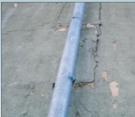
*Разрушение отделочных и армирующих слоев системы с проникновением воды в толщу теплоизоляционной плиты вследствие нарушений и неправильной эксплуатации отливов, сливов и кровельного покрытия*
