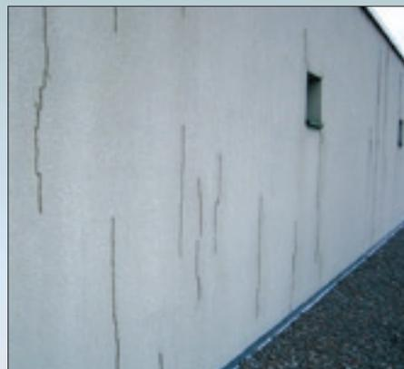
Попытки ремонта теплоизоляционного покрытия здания. Расширка трещин, возникших из-за отсутствия перехлеста сетки и внутренних напряжений армированного слоя
