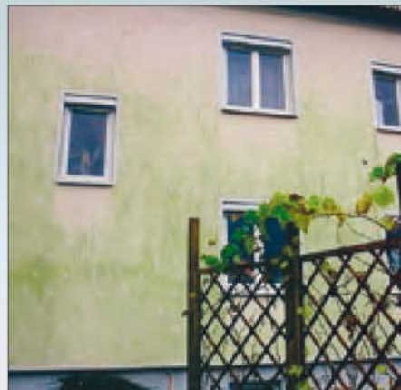
Загрязнения декоративного покрытия фасада здания от близко растущих деревьев и насаждений
