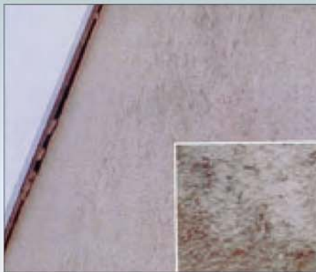
Возникновение и рост микроорганизмов возможно всегда как на минеральной штукатурке, так и на синтетической, на гладком и шероховатом или водоотталкивающим или липком основании
