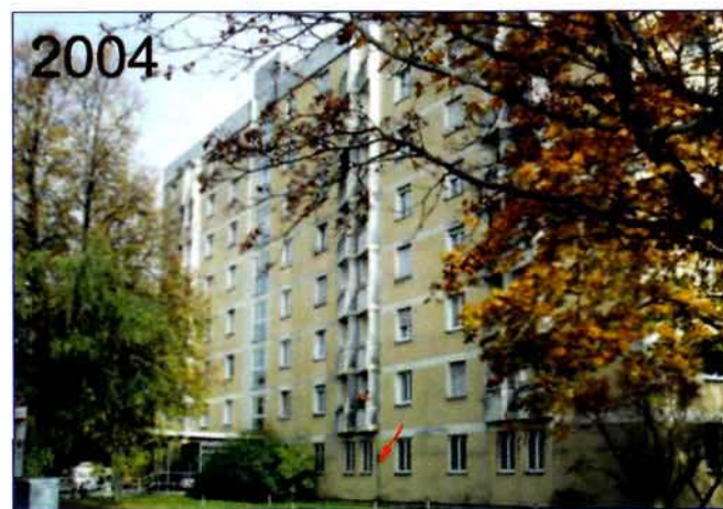
■ Рис. 14. Западный фасад объекта 16 в сентябре 1989 года, через три года после установления теплоизоляционных фасадов (слева) и 15 лет спустя, в ноябре 2004 года (справа). Отчетливо видно образование водорослей, в особенности на местах, подвергавшихся сильному воздействию влаги (см. стрелку и рис. 15)
