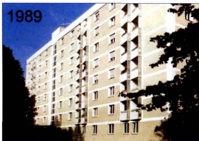
■ Рис. 14. Западный фасад объекта 16 в сентябре 1989 года, через три года после установления теплоизоляционных фасадов (слева) и 15 лет спустя, в ноябре 2004 года (справа). Отчетливо видно образование водорослей, в особенности на местах, подвергавшихся сильному воздействию влаги (см. стрелку и рис. 15)
