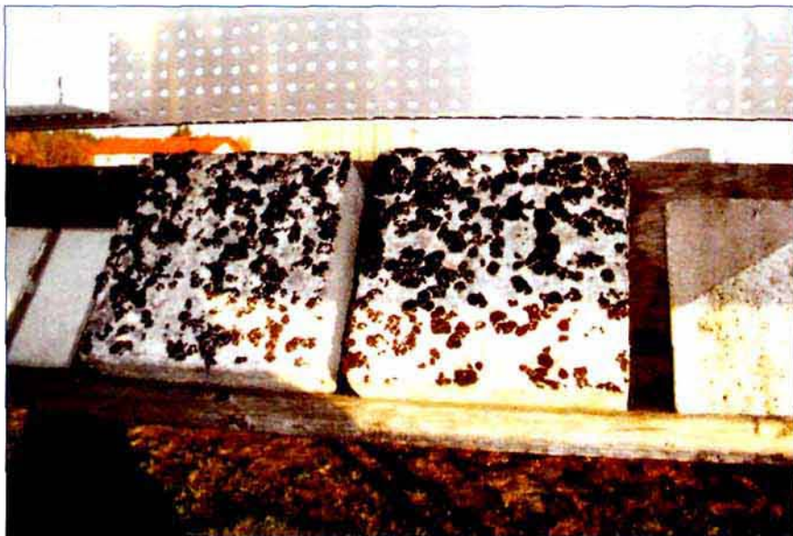
■ Рис. 6. Экспериментальный фрагмент теплоизоляционного фасада, установленный с отклонением от вертикали примерно на 30°, ориентированный на запад, через 12 лет после установки. Значительно более высокое воздействие выпадающих осадков вследствие наклона поверхности привело к полному разрушению поверхностного слоя штукатурки и, как следствие, к сильному разрастанию мха на поверхности фасада.
