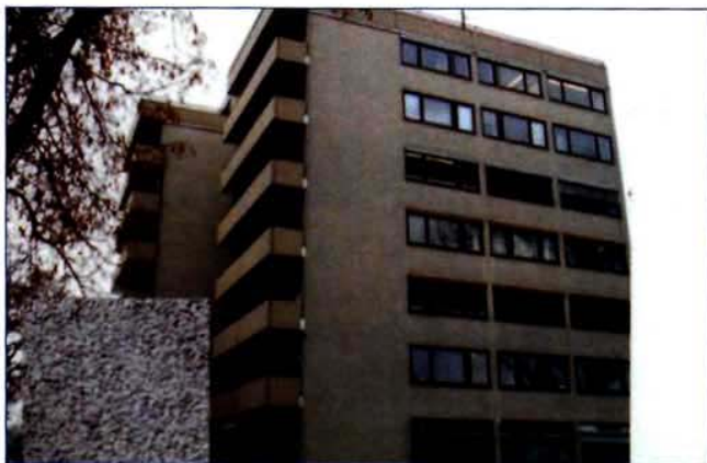
■ Рис. 12. Восточный и южный (справа) фасады объекта 54 в декабре 2004 года, через 16 лет после ремонта в 1988 году при помощи покраски. В маленьком фрагменте фотографии представлена съемка штукатурки крупным планом. Произошло равномерное загрязнение штукатурки
