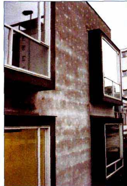
■ Рис. 7. «Эффект леопарда» – узор на фасаде здания – однозначный признак микробиологического обрастания из-за образования конденсированной воды на поверхности фасада
