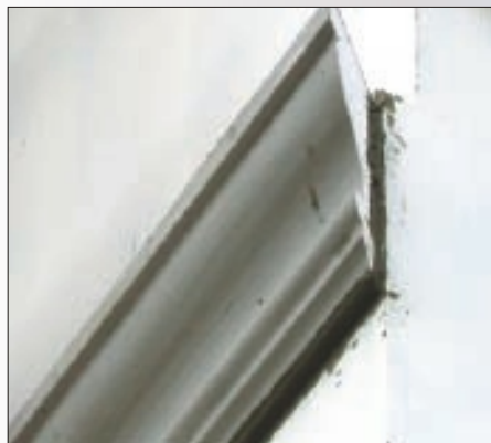
Установка архитектурных элементов на клеевой слой без дополнительного дюбельного крепления и армирования на поверхность теплоизоляционной системы
