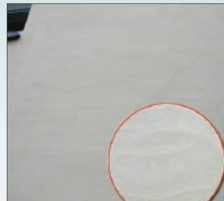
Шпаклевание поверхности произведено неподходящими материалами с большей плотностью, что вызвало растрескивание и вспучивание декоративных отделочных слоев
