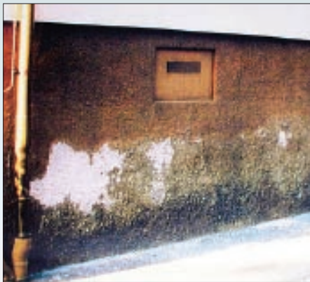
При разработке цветового решения был выбран недопустимый оттенок покрытия (слишком темный цвет и слишком контрастная расцветка)
