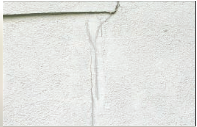
Появление трещин на декоративном покрытии из-за отсутствия деформационного шва на границе утепляемых и неутепляемых конструкций.
