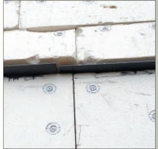
Применение дюбелей, полностью выполненных из металла, приведет к локальным промерзаниям и разрушениям декоративно-защитного слоя.
