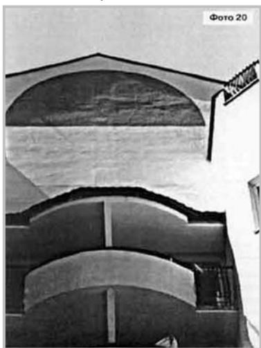
Толщина декоративно-защитного слоя в 2-2,5 раза меньше регламентируемого в ТС (№ ТС-07-276-2000). Соответственно, все неровности плохо подготовленного утеплителя легко "читаются" на фасаде, особенно при боковом освещении. Фото 19, 20.
